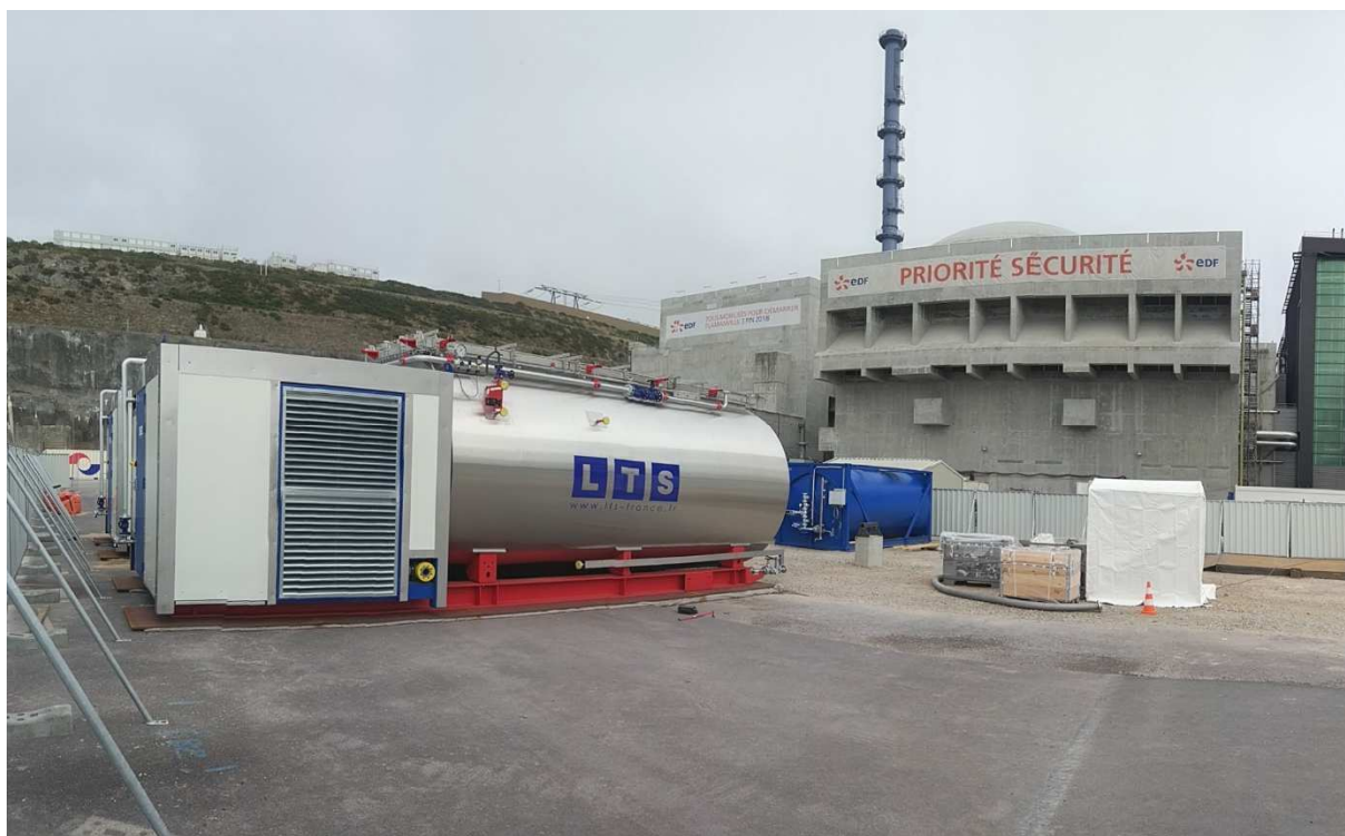
Deux chaudières LTS en cours d'installation pour la mise en service de l'EPR EDF de Flamanville
