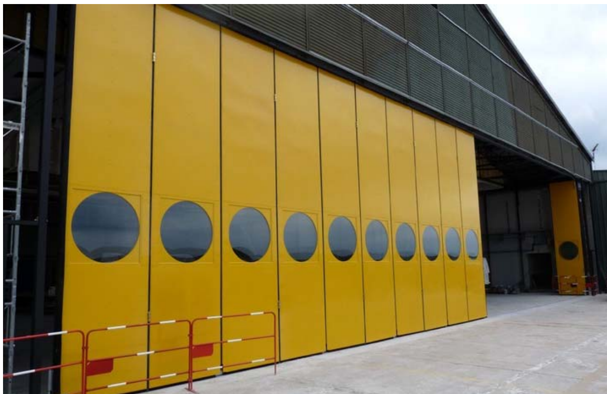
Porte accordéon roulante Mineur-Bécourt pour la base aérienne de Saint Dizier / Largeur 26m x Hauteur 6m
